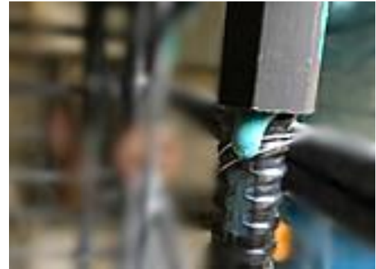
挿入マーク長さ40mmの所、40mm以上有り
